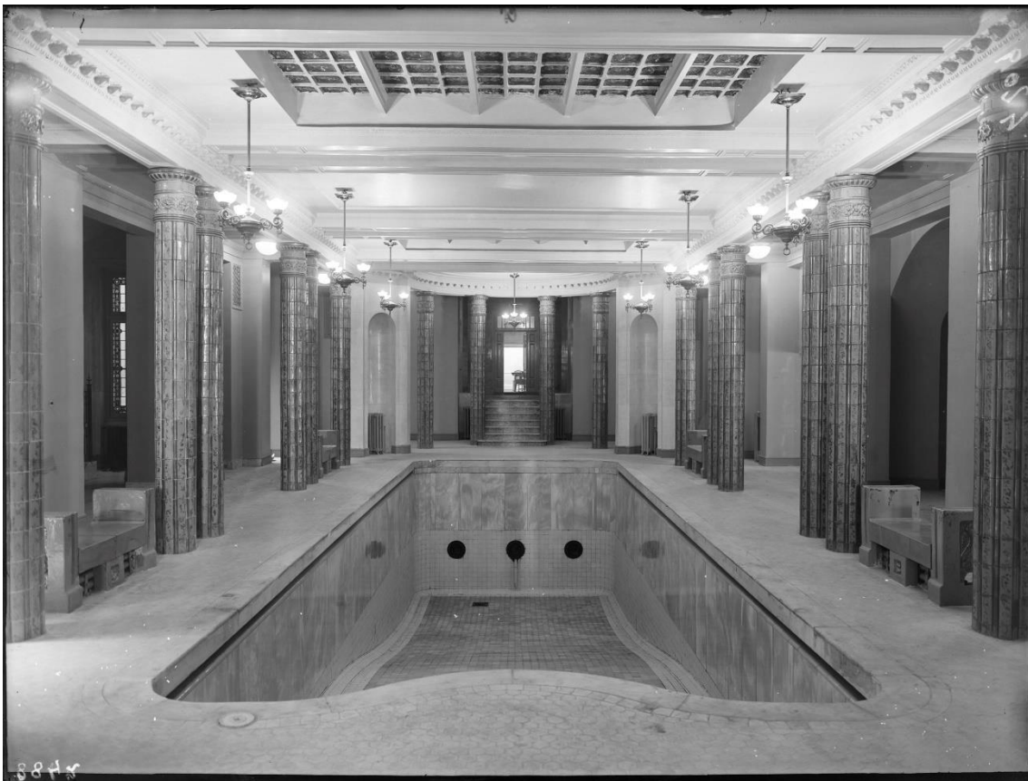
Piscina interior en el sótano del edificio del Círculo de Bellas Artes. / Luis Lladó
