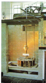
Turbina, cámara abierta, de Central Villaverde. 1898.
