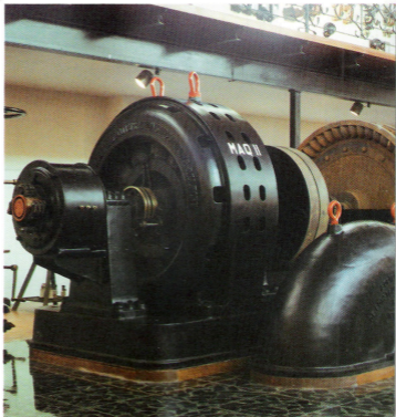
Grupo número II de la Central de Mao (Orense). Turbina y alternador. Fue retirado de dicha central en 1988.
